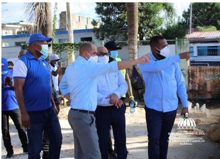
El vicepresidente por Santo Domingo Norte, José Santana le explica a Rolfi Rojas como avanzan los trabajos de construcción del Multiuso.
