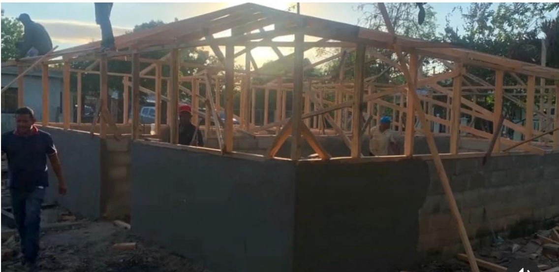
Proceso de construcción de vivienda.
