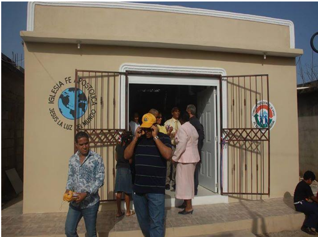
Parte frontal de la iglesia Fe Apostólica en Brisa del Este.
